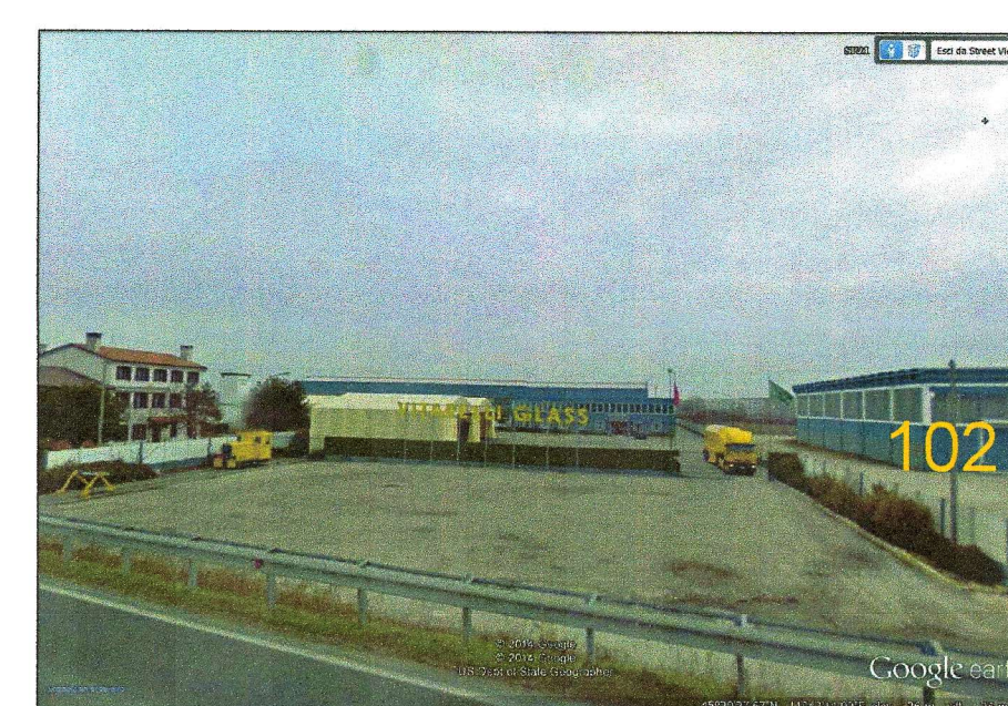
102 - progr. km 62.7 FABBRICATO DA DEMOLIRE
