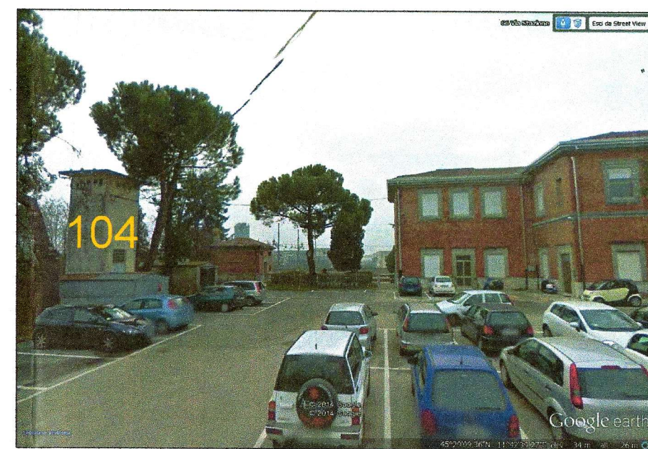
104 - Stazione Grisignano progr. km 62.7 FABBRICATO FERROVIARIO DA DEMOLIRE
