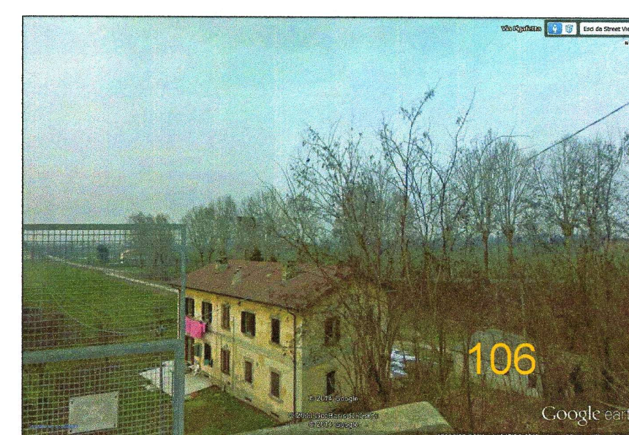
106 - progr. km 64 FABBRICATO DA DEMOLIRE
