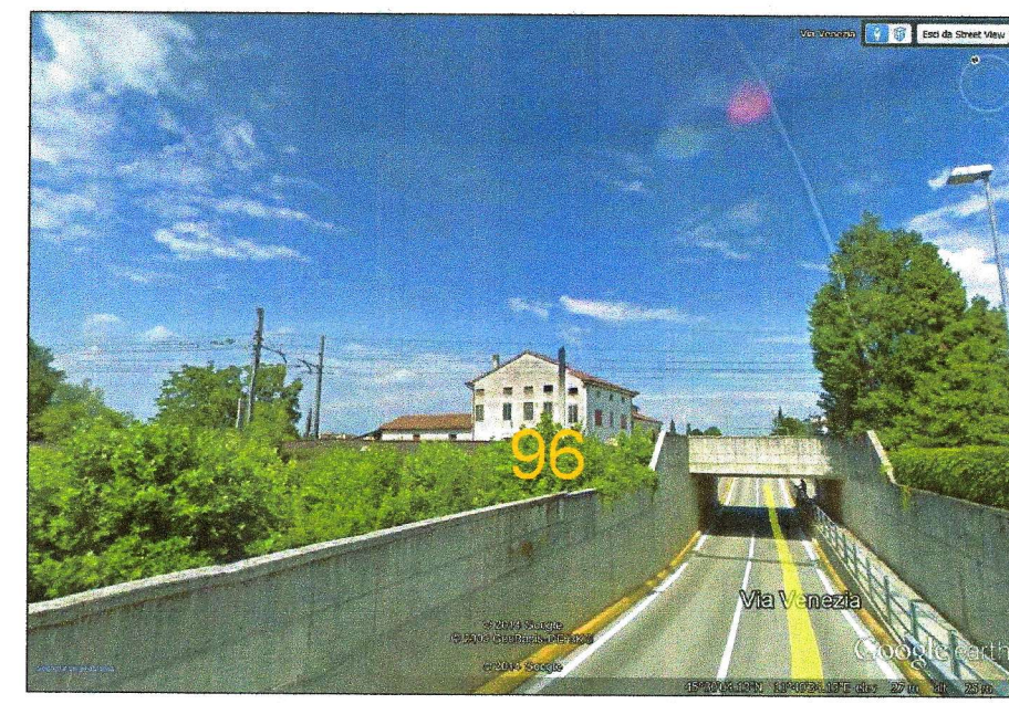
96 - via Marconi progr. km 60.3 FABBRICATO DA DEMOLIRE
