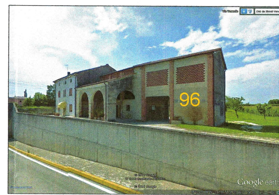
96 - via Marconi progr. km 60.3 FABBRICATO DA DEMOLIRE
