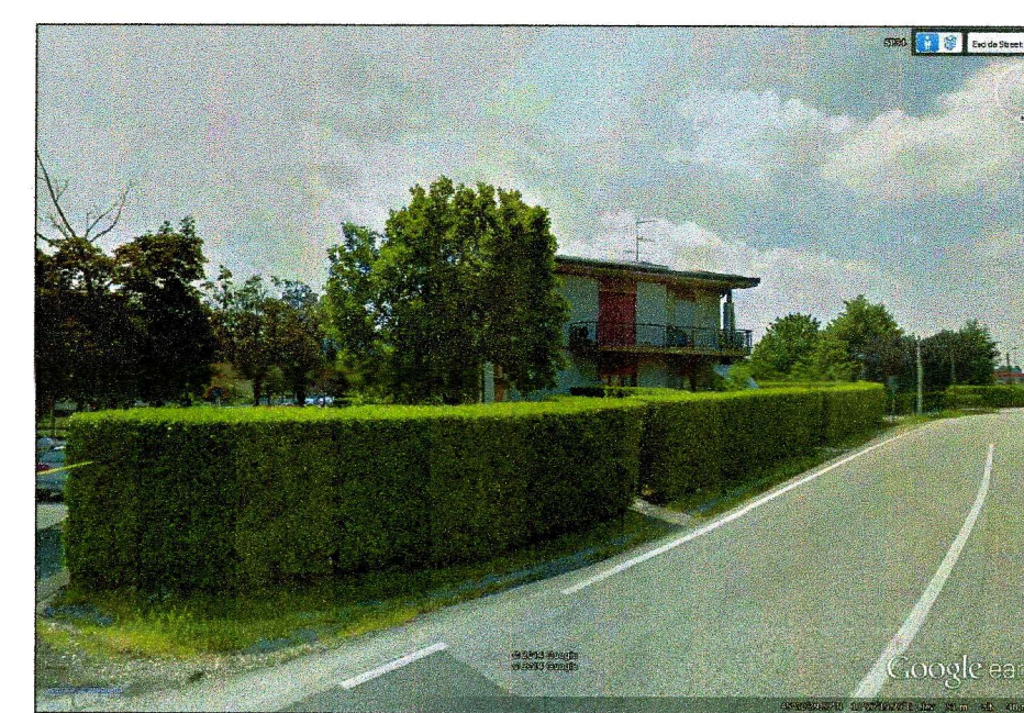
25 - FABBRICATO DA DEMOLIRE
