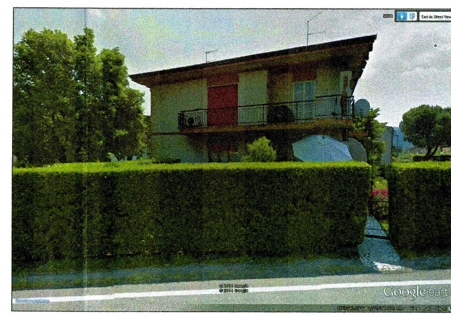
25 - FABBRICATO DA DEMOLIRE
