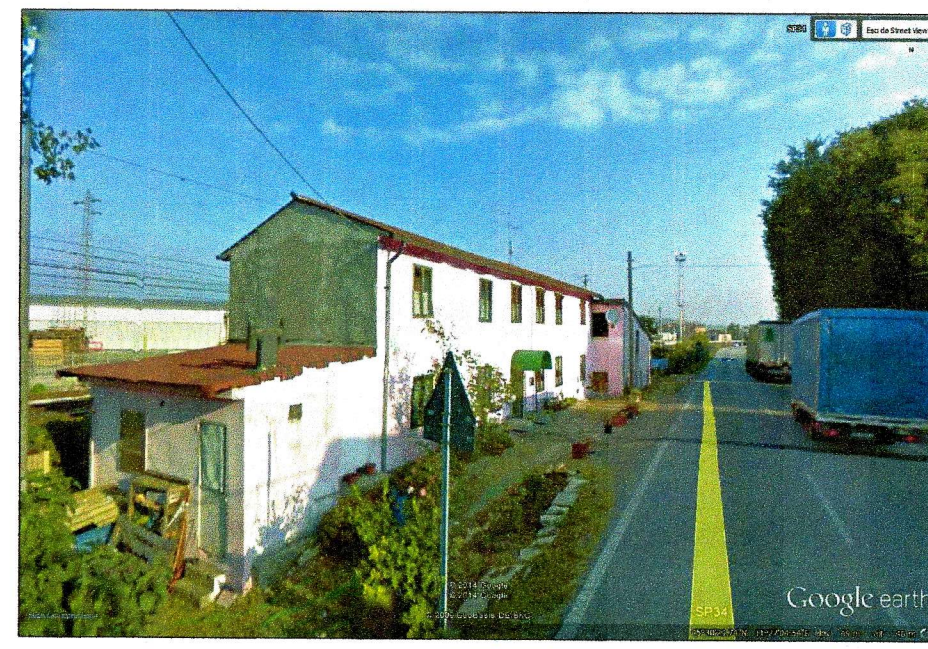
24 - FABBRICATO DA DEMOLIRE
