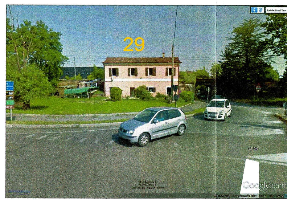
27-28-29 - FABBRICATI DA DEMOLIRE
