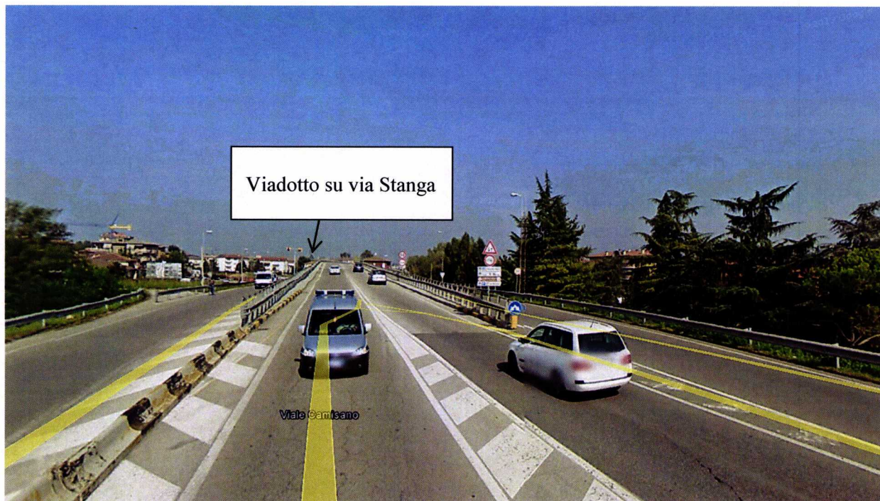
Via Camisano – Cavalcaferrovia esistente Vista da Sud (ferrovia alle spalle)
