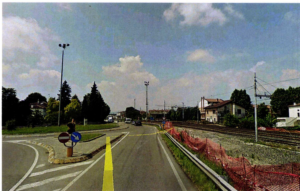
Sottovia esistente Km 41+260 – Rotatoria SP34 vista lato Ovest
