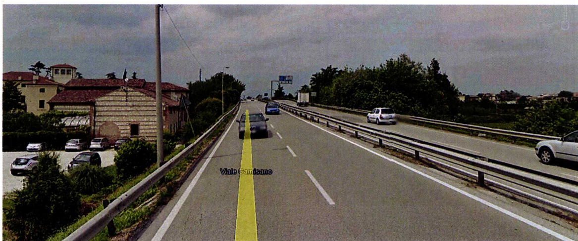
Via Camisano – Cavalcaferrovia esistente- vista da Sud
