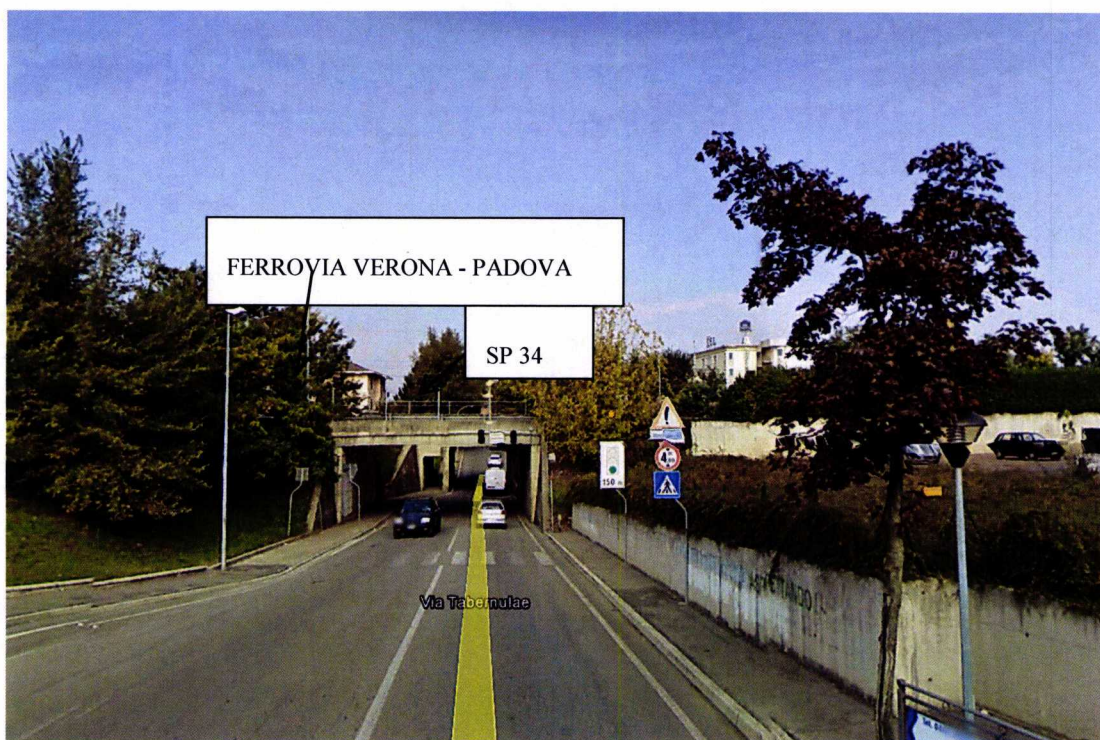
Sottovia esistente Km 41+260 – Imbocco lato Sud
