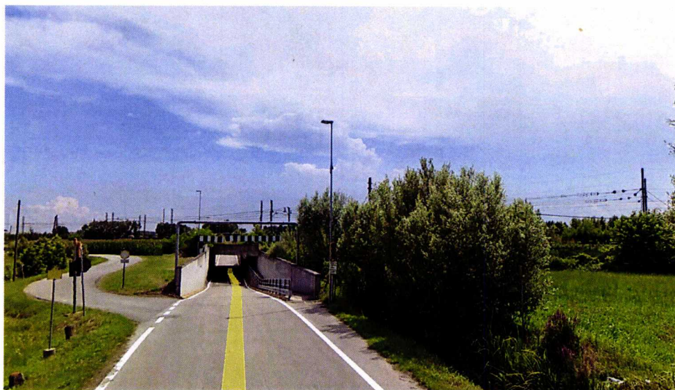
Sottovia esistente Km 59+160
