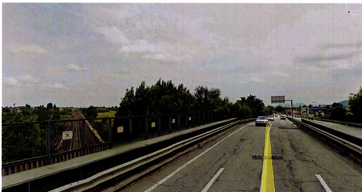
Via Camisano – Cavalcaferrovia esistente Vista da Sud ( lato ampliamento sede ferroviaria)
