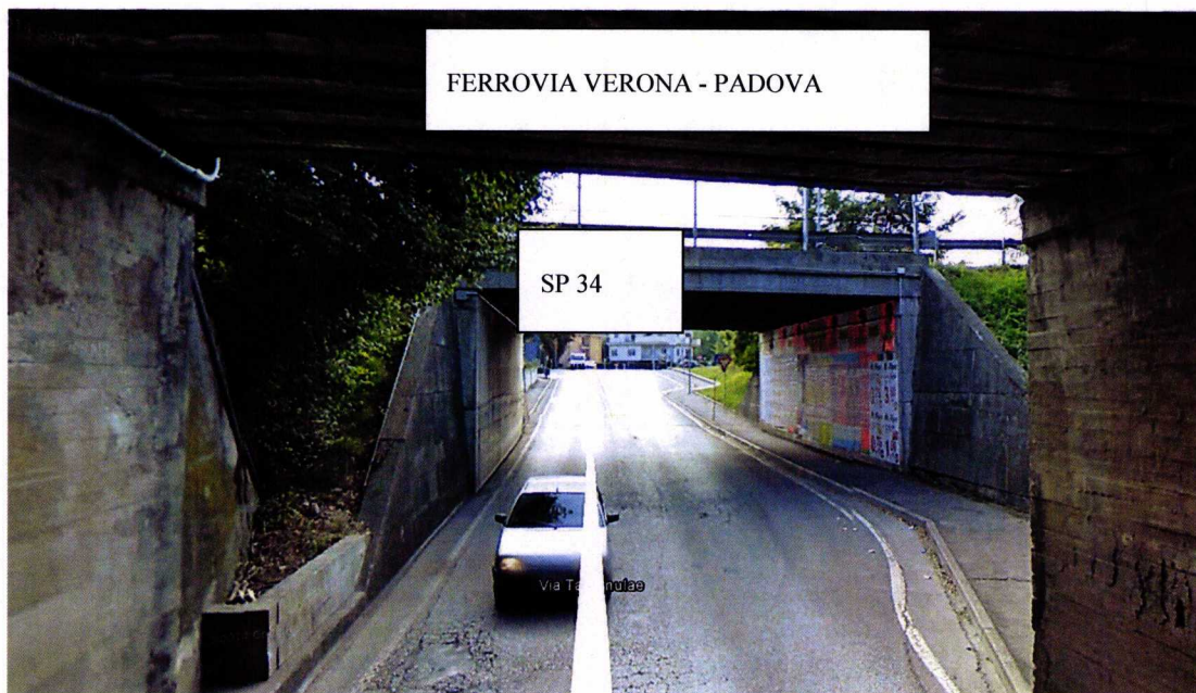
Sottovia esistente Km 41+260 – Imbocco lato Nord
