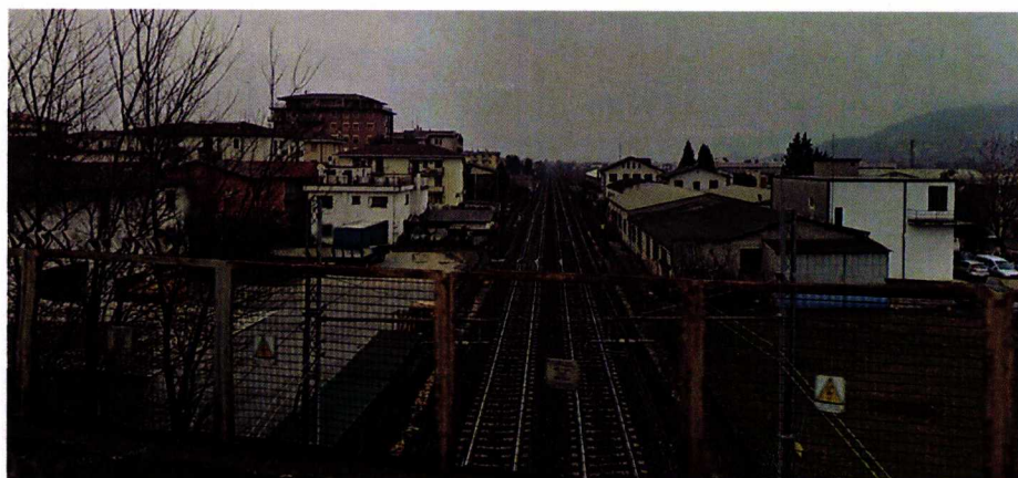
Cavalcavia esistente Km 38+180 – Vista direzione Nord-Est (Verona)
