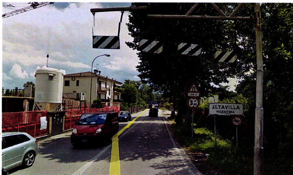
Ponte ferroviario esistente Km 43+900 – Imbocco lato Nord
