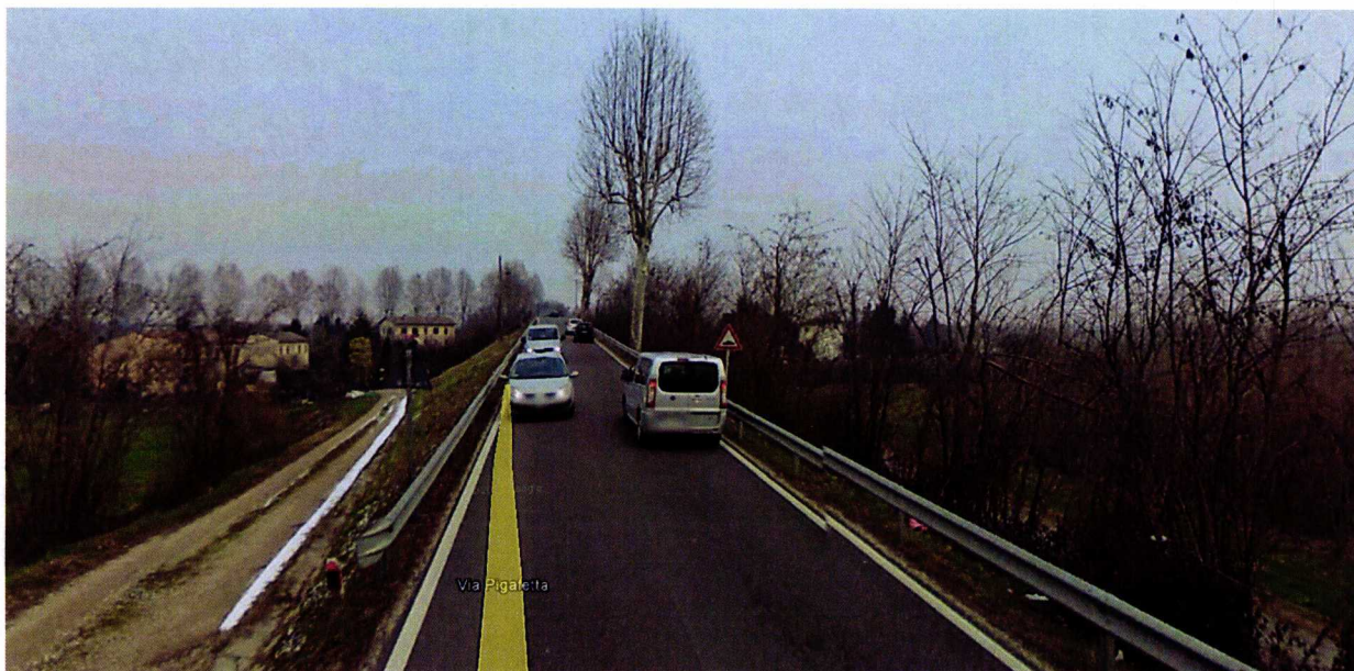
Cavalcavia esistente Km 64+034 – Vista da Sud
