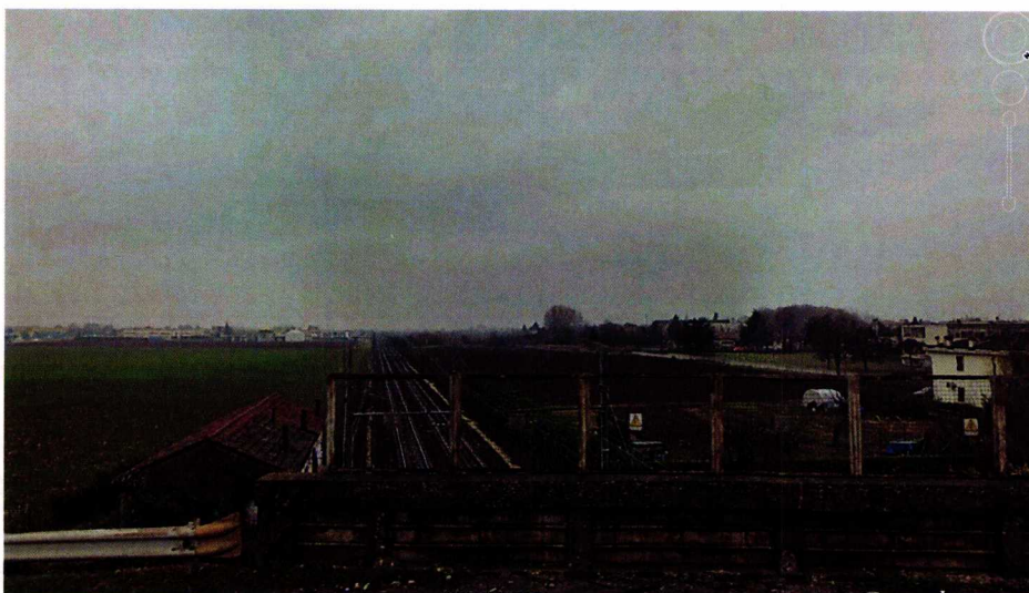
Cavalcavia esistente Km 38+180 – Vista direzione Sud - Ovest
