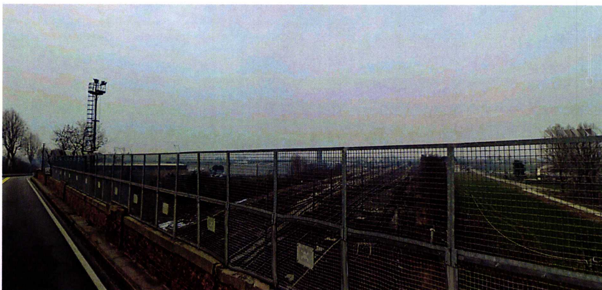
Cavalcavia esistente Km 64+034 – Vista da Nord
