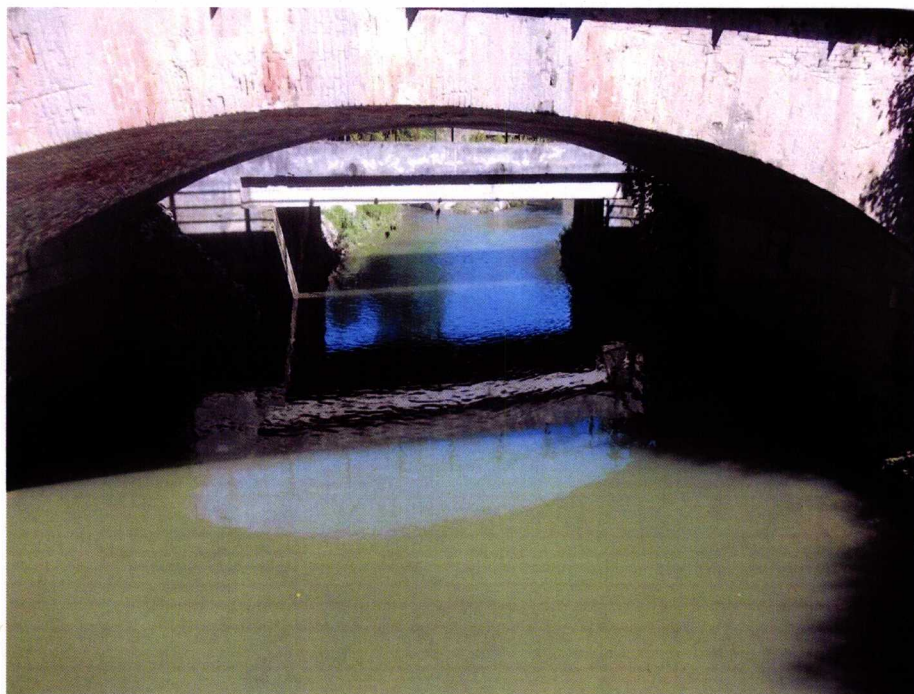
Figura 11 – Attraversamento roggia Dioma linea singolo binario (in secondo piano).
