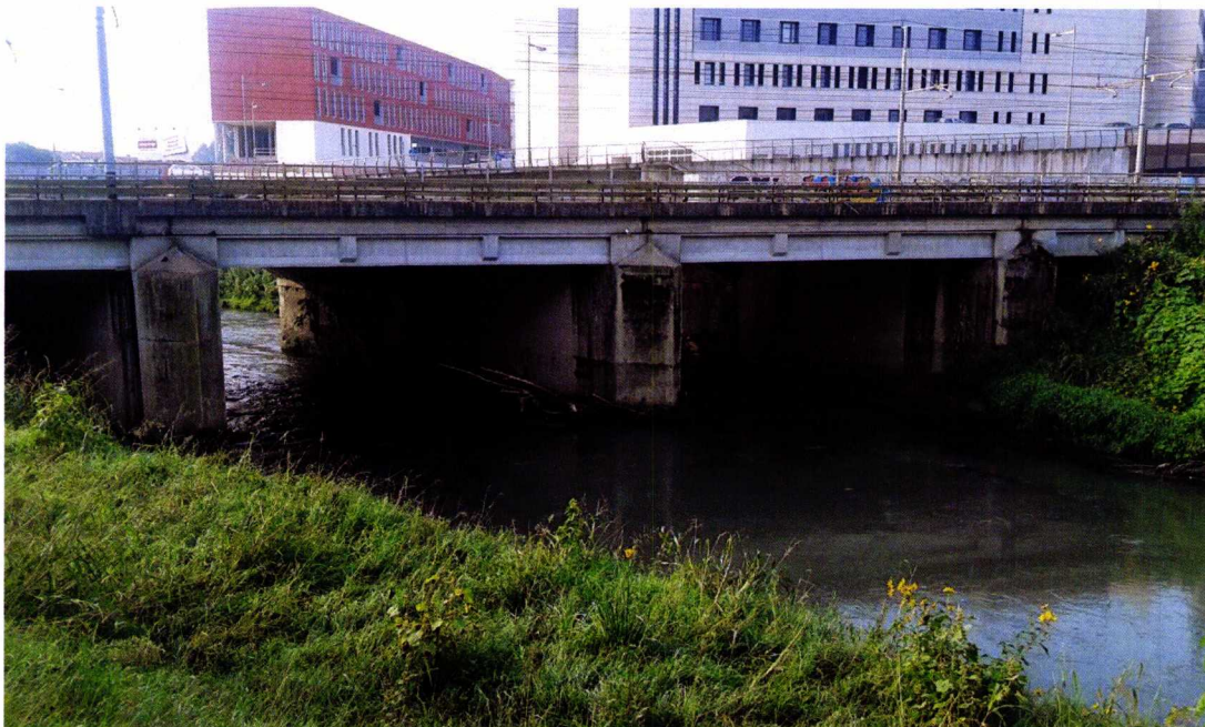
Figura 13 – Attraversamento fiume Bacchiglione, vista da monte.
