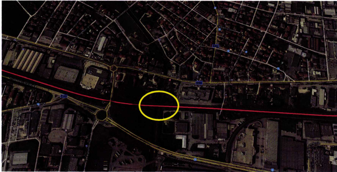
Figura 3 – Prima intersezione fiume Retrone con la nuova linea AV/AC evidenziata in rosso.
