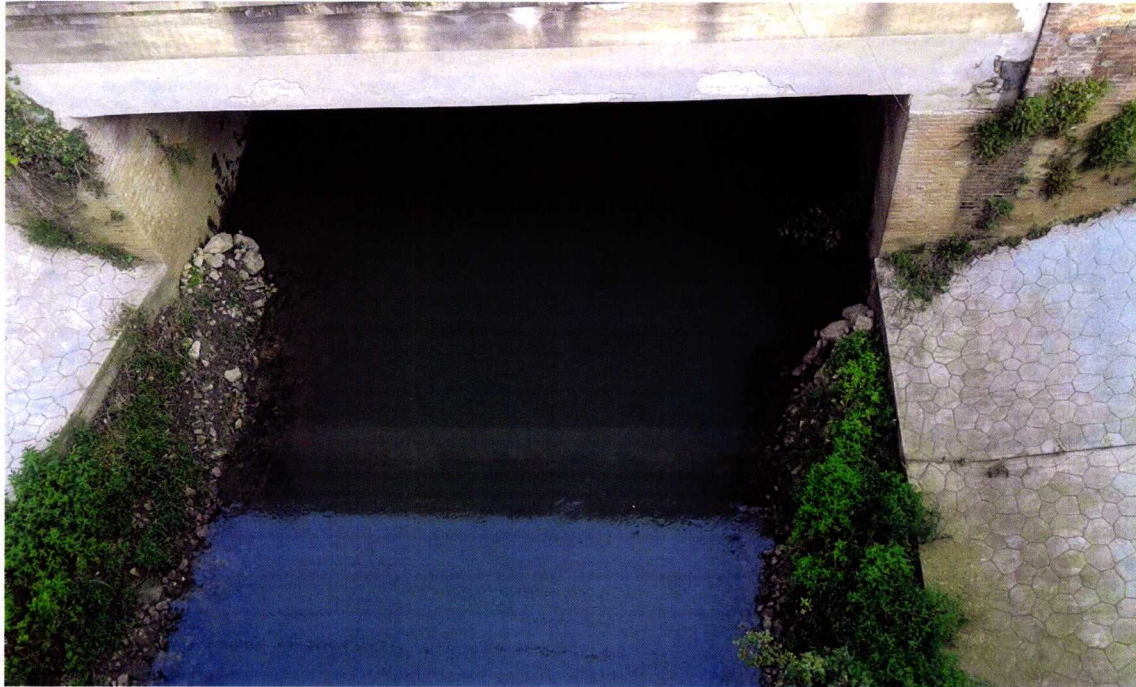
Figura 8 – Terzo attraversamento sul fiume Retrone.
