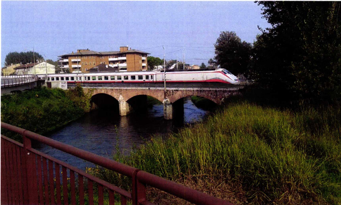
Figura 14 – Attraversamento fiume Bacchiglione, vista da valle.
