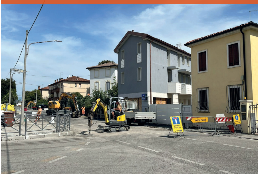
Lavori in stradella Mora
