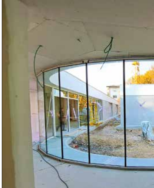
Nuovo Nido di via Turra, cantiere al mese di marzo 2026
