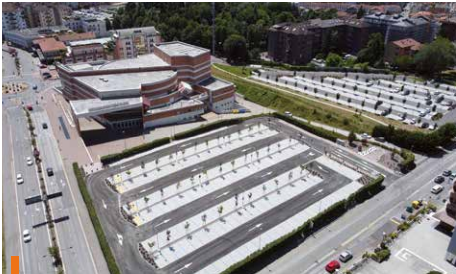
Una panoramica dall'alto del nuovo parcheggio e di quello attiguo realizzato lo scorso anno nell'area ex acciaierie Valbruna
