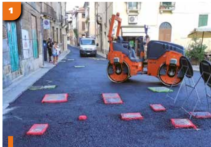
Alcune fasi di lavorazione, ora conclusa, nelle contrà San Paolo e Ponte San Paolo.
