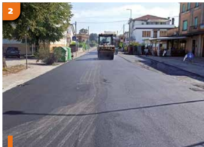
Concluso anche l'intervento in Strada delle Maddalene.
