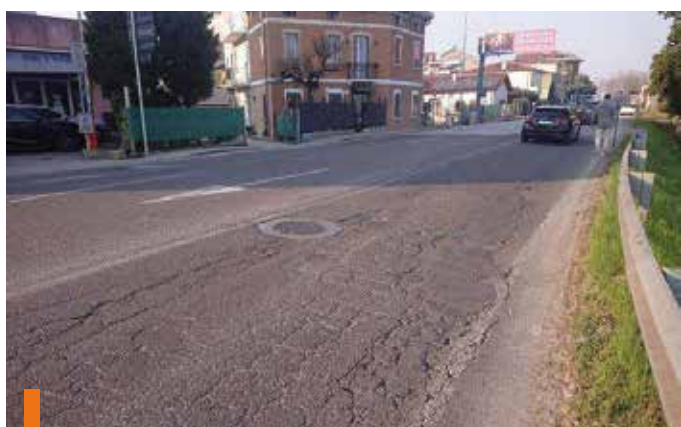
La situazione lungo strada Marosticana prima e dopo l'intervento di asfaltatura
