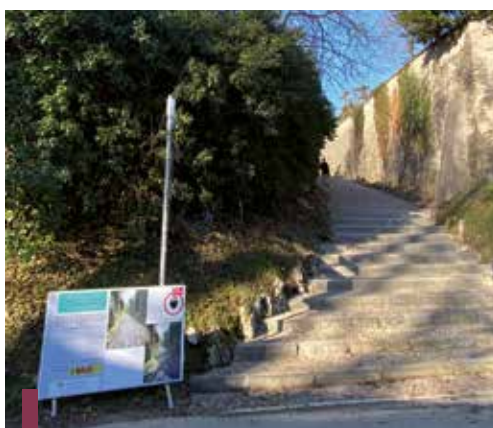
La scalinata d'accesso del sentiero completamente rimessa a nuovo
