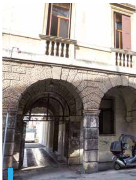
L'ex studentato di San Marco che sarà riqualificato e diventerà sede di Housing temporaneo
