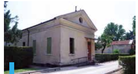
Gli esterni dell'immobile nel parco San Felice destinato ad accogliere persone anziane non autosufficienti
