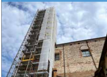
Restauro e consolidamento del campanile di San Giuliano
