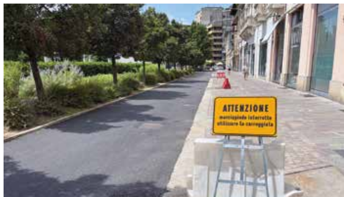
Cantiere in viale Verdi
