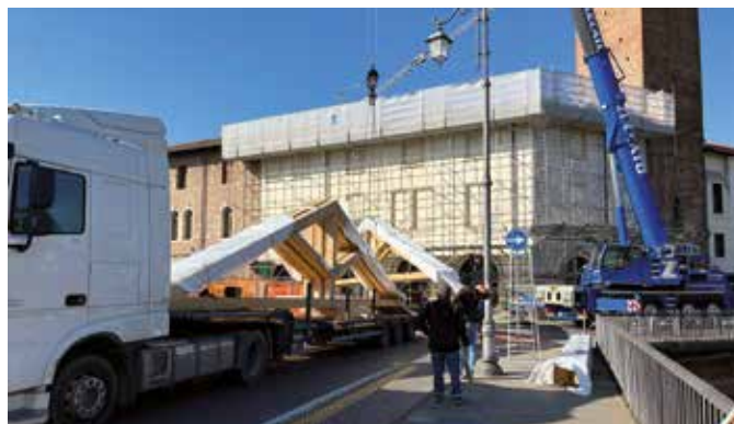
Lavori al Palazzo del Territorio
