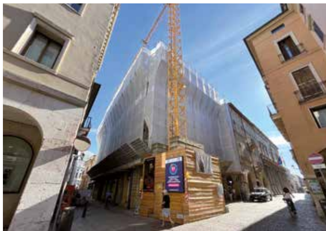
Palazzo Trissino, sede del Comune: restauro del tetto e interventi sulle facciate per 1,5 milioni di euro
