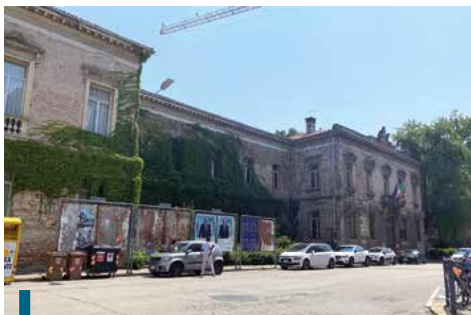
L'esterno della scuola vista da Piazzale Giusti; l'intervento la restituirà alle associazioni più sicura e funzionale
