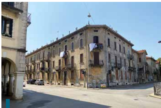
Il palazzo di via Bonollo che ospita alloggi popolari
