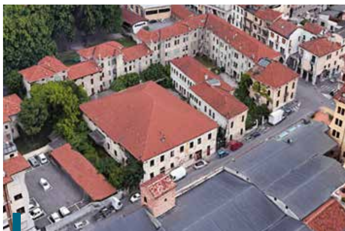
Una veduta aerea dell'ex caserma della Guardia di Finanza in contrà della Rocchetta che sarà ristrutturata e trasformata in nuovi alloggi Erp
