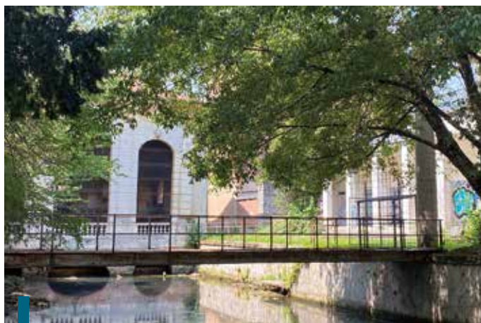
La facciata della loggetta Longhena, una struttura in abbandono ma che verrà completamente restaurata e resa fruibile alla cittadinanza
