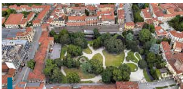
L'area dall'alto dei giardini Salvi comprendente gli immobili dell'ex fiera, del cinema Arlecchino, della loggetta Longhena e dell'ex scuola Giusti, tutti interessati da profonde ristrutturazioni finanziate dallo Stato su richiesta del Comune di Vicenza
