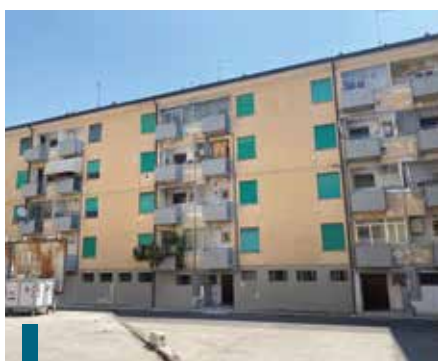
La facciata esterna dei palazzi mostra chiaramente l'usura di costruzioni anni '50
