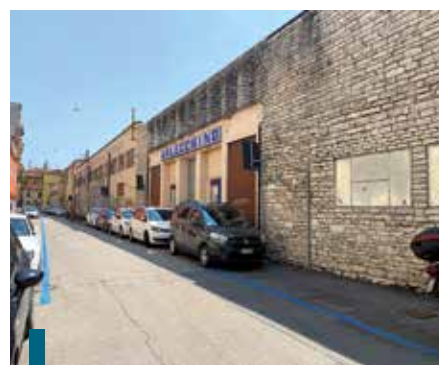
L'esterno del cinema in Contrà Mure Porta Nova il cui restauro darà uno spazio in più alla comunità rivitalizzando tutta la zona
