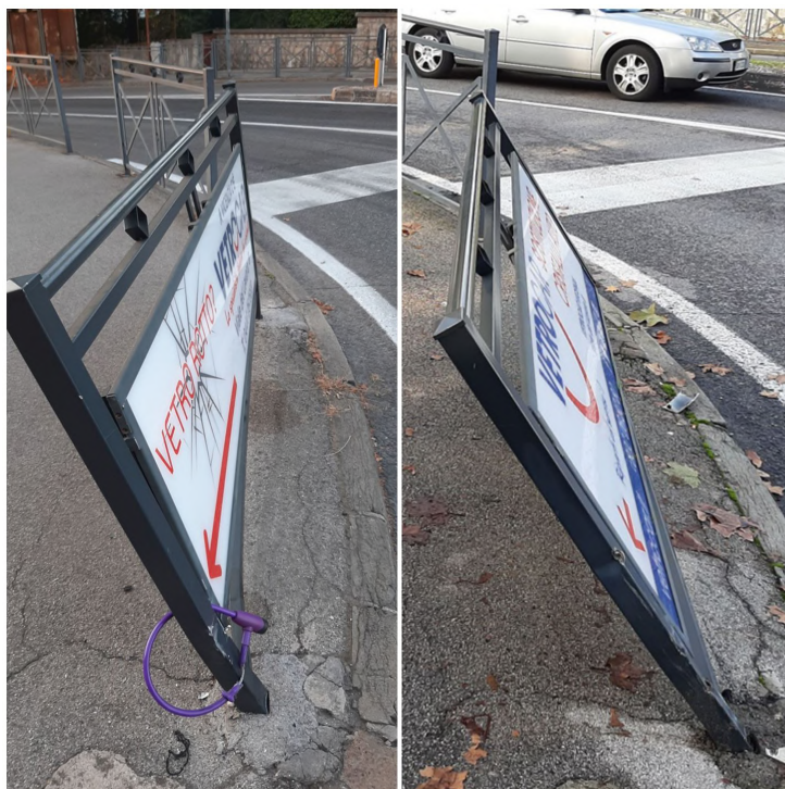
Foto 2 – Transenne danneggiate da auto provenienti da viale Risorgimento (in tempi diversi)
