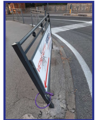
Transenna esistente I frequenti danni causati dall'urto delle auto non rendono sicura la sosta
