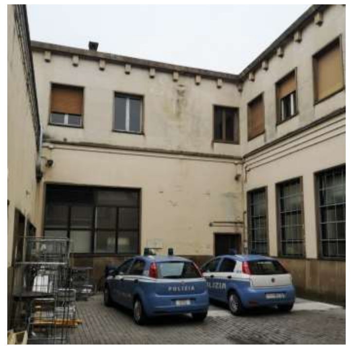
1) CORTILE DI ACCESSO ALLA POLFER
