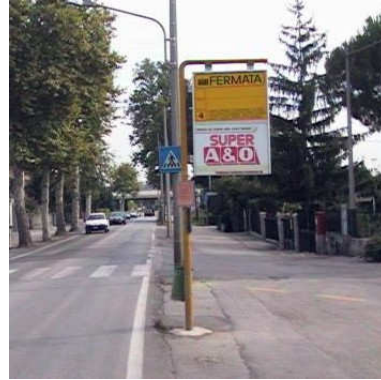
Impianti abbinati a palina fermata bus, commerciale
