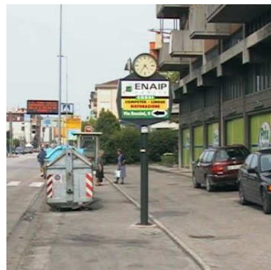
Impianti abbinati a elementi di arredo urbano
