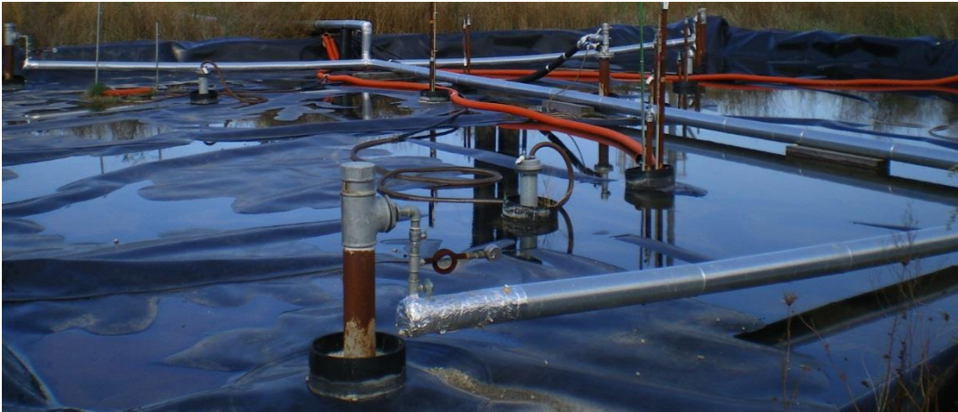
Figura 14: esempio di copertura con telo in HDPE di un'area oggetto di desorbimento termico
