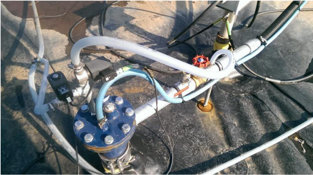
Figura 10: esempio di completamento testa pozzi di un MPE
