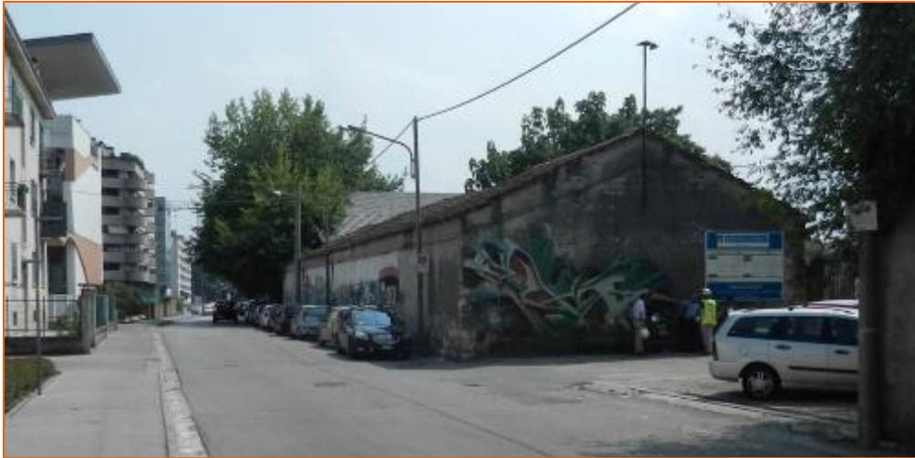
Figura 2: Edificio R'; inquadratura da Via Monte Zovetto (da nord, esterno all'area di cantiere)
