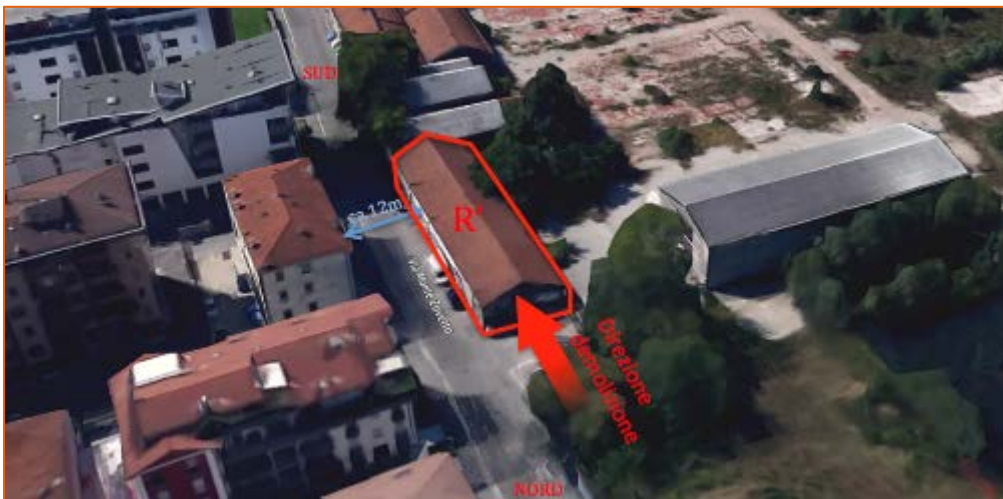
Figura 3: Edificio R'; inquadramento tridimensionale con indicazione delle zone di interferenza più vicine
