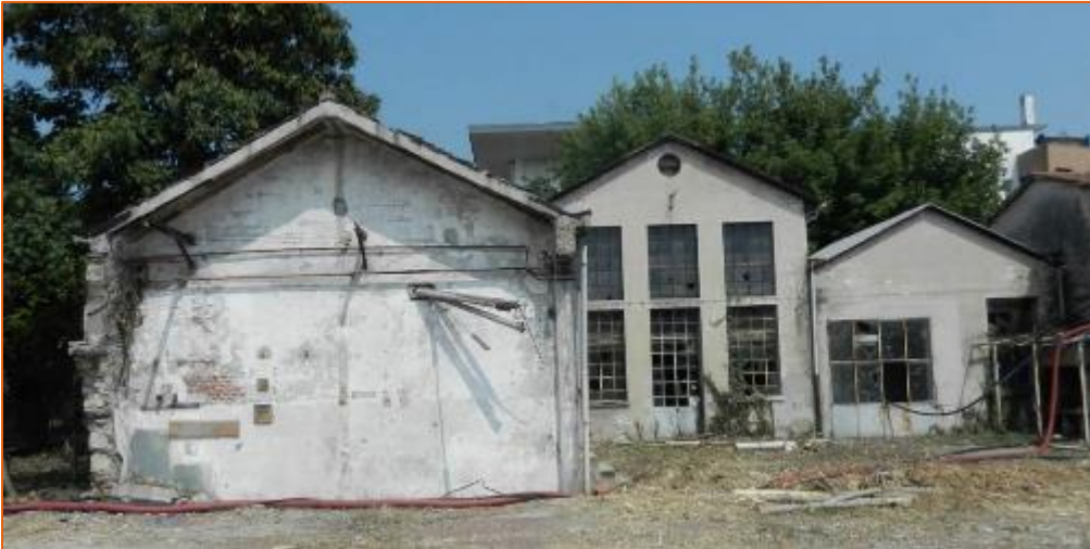
Figura 4: Edifici R, R'' e D; inquadratura da ovest (interno dell'area di cantiere)
