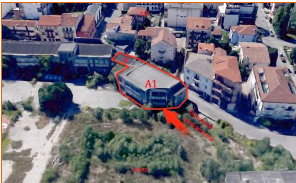
Figura 1: Edificio A1 e A' – Direzione di demolizione
