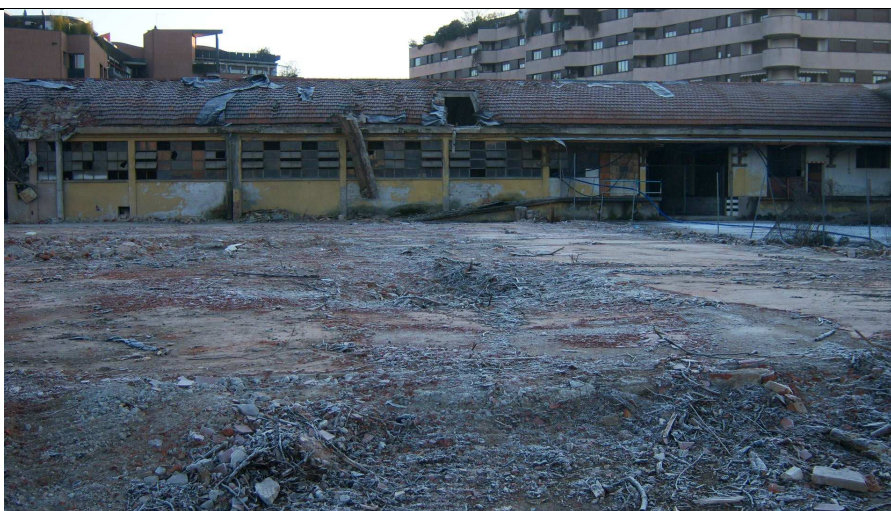
Figura 7.13 : Edificio F – Area di deposito materiali
