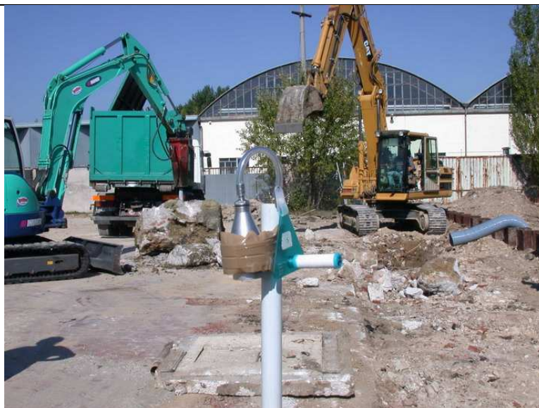
Figura 8.1 : Postazione di monitoraggio in prossimità delle aree di bonifica
