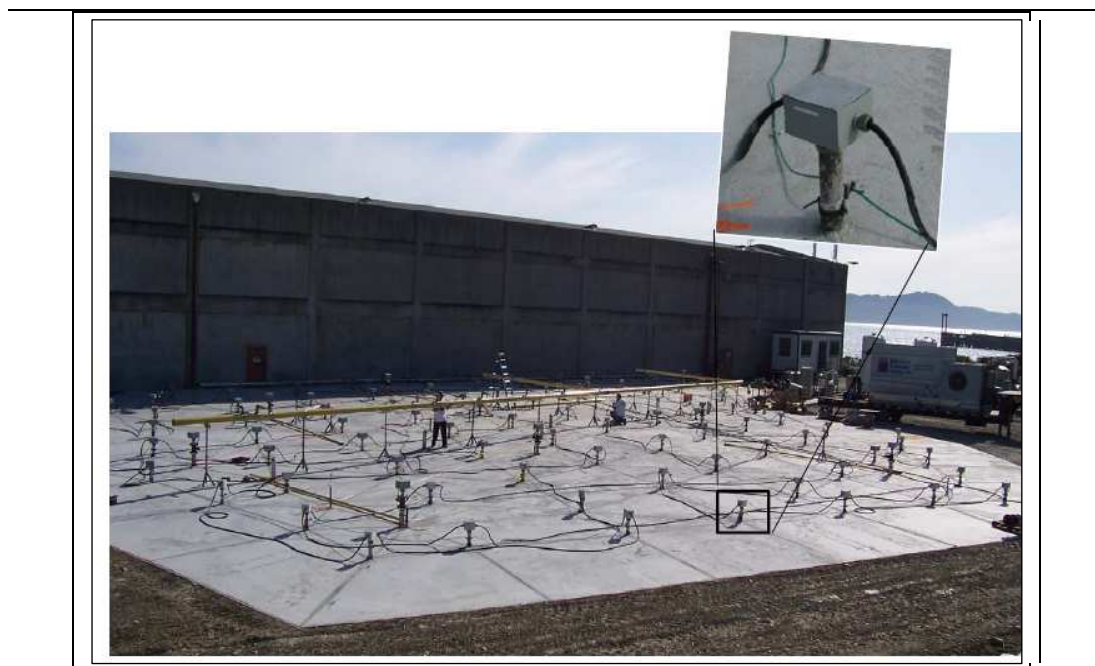
Figura 7.3 : Isolamento sommitale dell'area di trattamento
