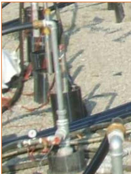
Figura 72: Foto testa pozzo con drop tube
