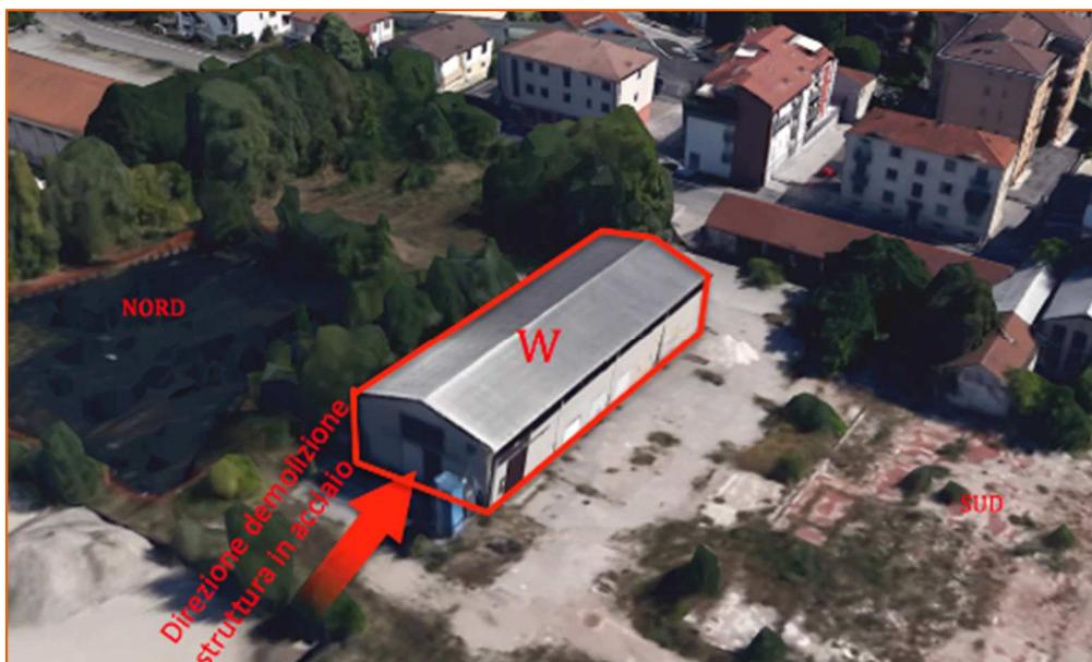
Figura 22: Edificio W: vista 3D con indicazione della direzione di avanzamento della demolizione
