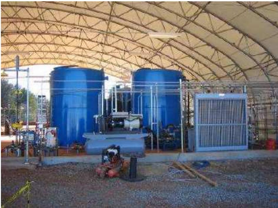
*Figura 44: Impianto di trattamento a carboni attivi rigenerati a vapore*
