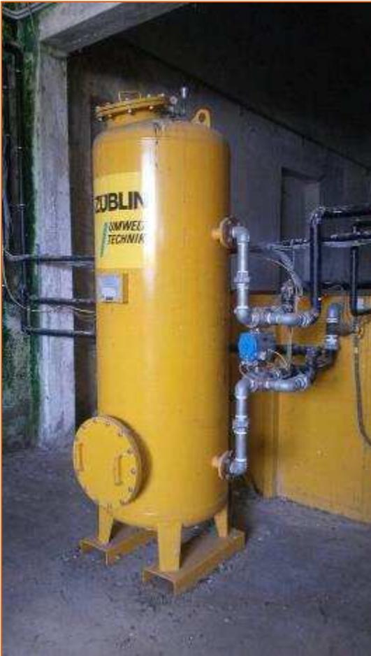
Figura 7: Particolare del filtro a sabbia
