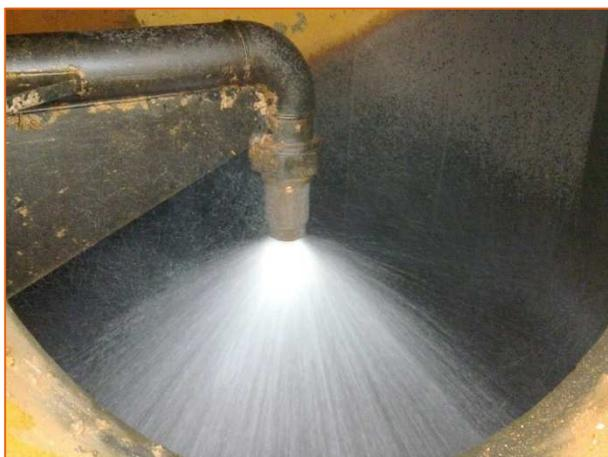
Figura 11: Particolare dell'ugello interno alla torre di strippaggio
