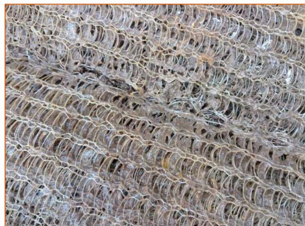
Figura 12: Particolare del demister interno della torre
