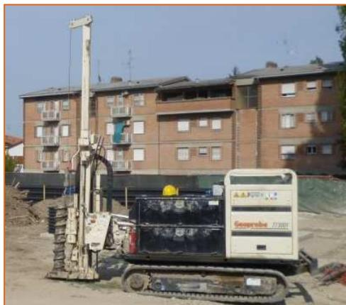
Figura 70: Sonda perforatrice con aste ad elica
