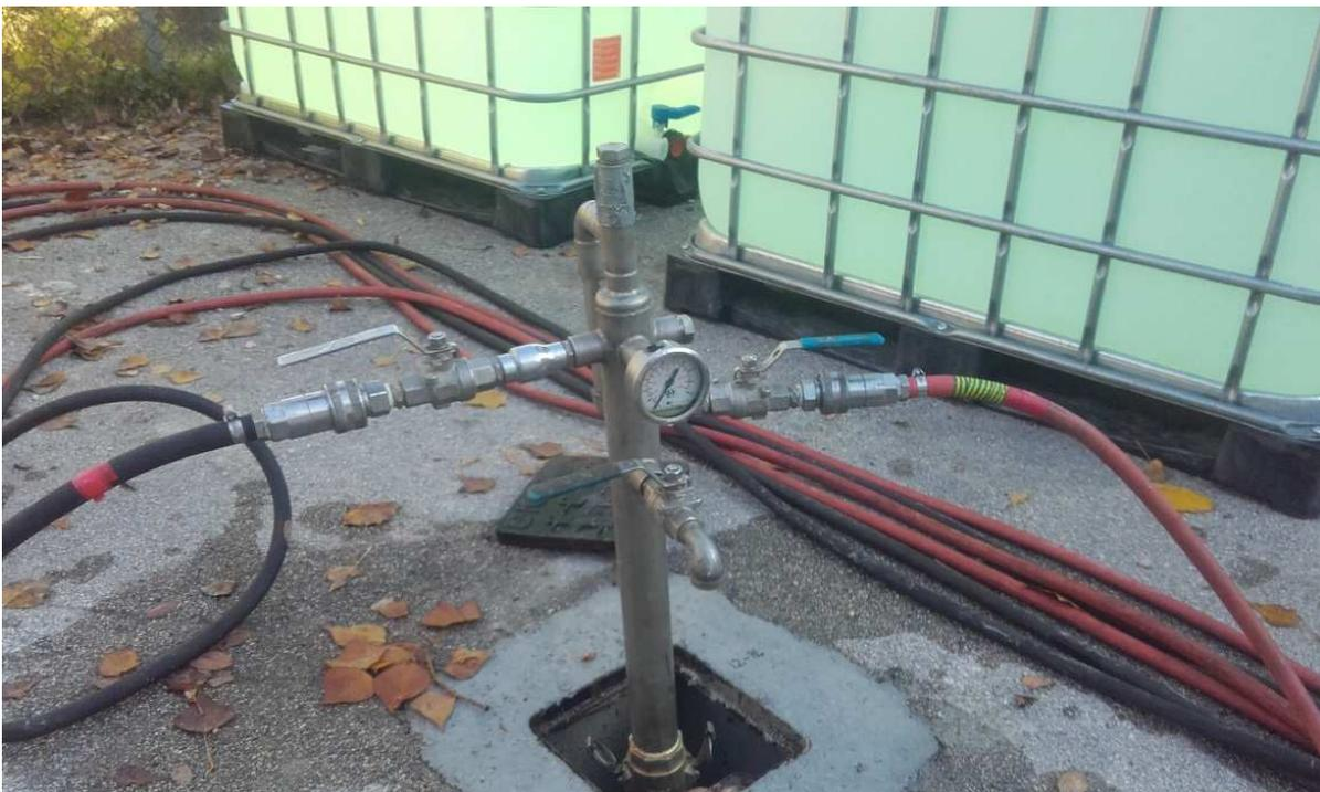
Figura 55: Particolare collegamento a testa pozzo
