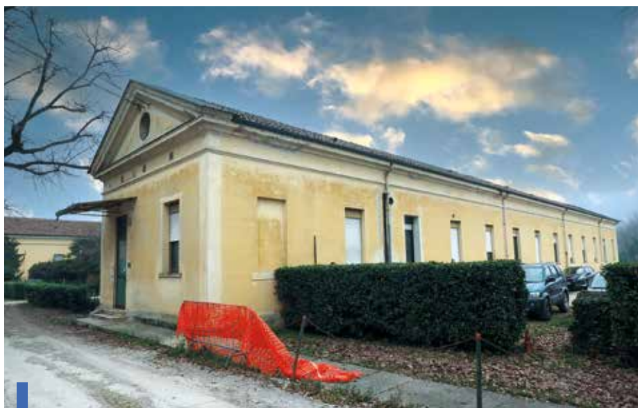
L'ex padiglione del complesso Ulss a San Felice dove verranno realizzati 6 mini appartamenti protetti con dotazioni e maggiori servizi domiciliari "a misura dell'anziano" per un importo complessivo di 2 milioni e 460 mila euro, distribuiti anche per altri progetti fuori comune.
