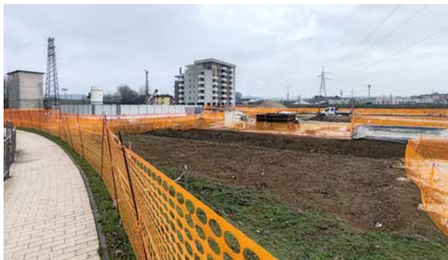
Cantiere a Ponte Alto
