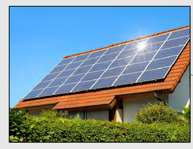
ESEMPIO DI PANNELLI FOTOVOLTAICI
