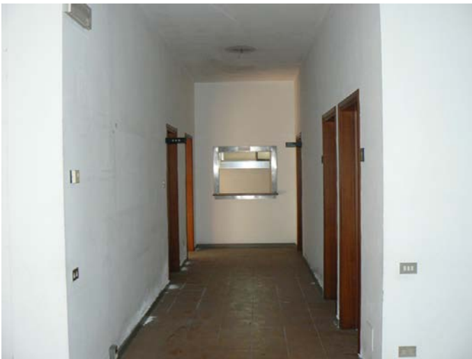
palazzina uffici: interno 3
