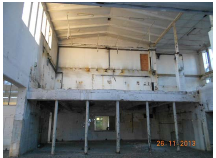
ex centrale del latte: interno 13 P.T.
