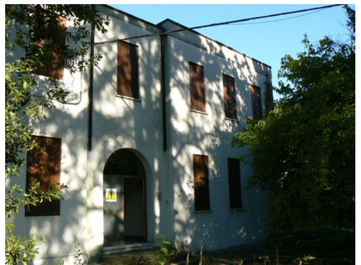
palazzina uffici: prospetto sud
