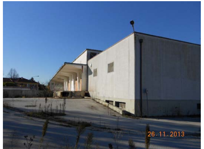
ex centrale del latte: angolo sud-est
