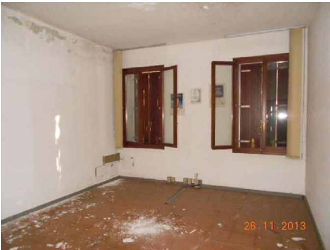
palazzina uffici: interno 9
