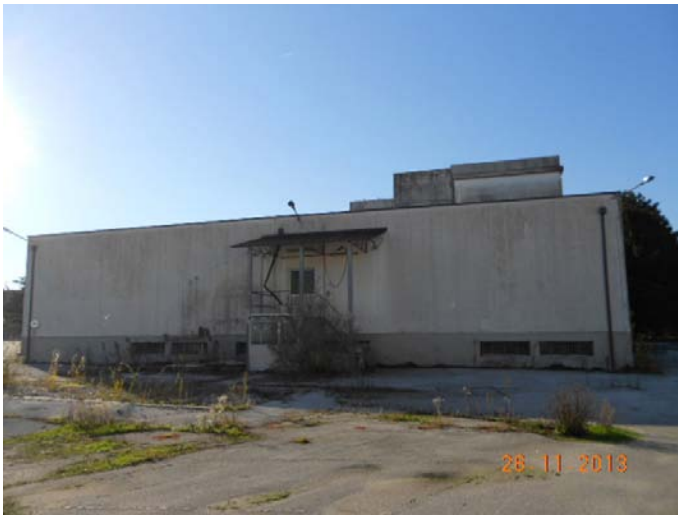
ex centrale del latte: prospetto est
