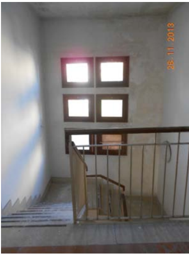
palazzina uffici: interno 7
