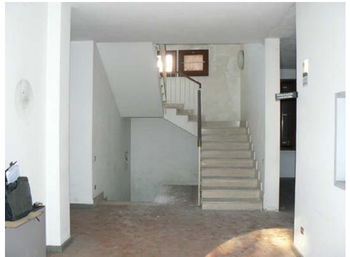
palazzina uffici: interno 2
