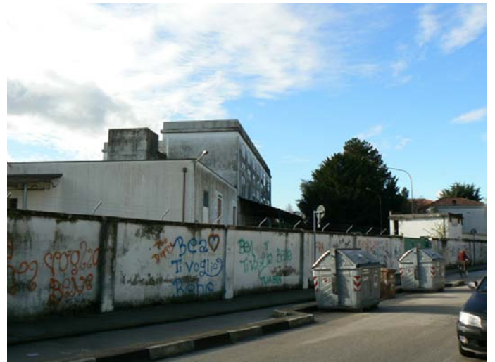
vista 2 - muri di recinzione lato nord
