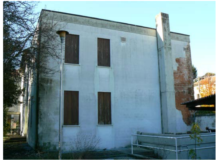
palazzina uffici: prospetto est
