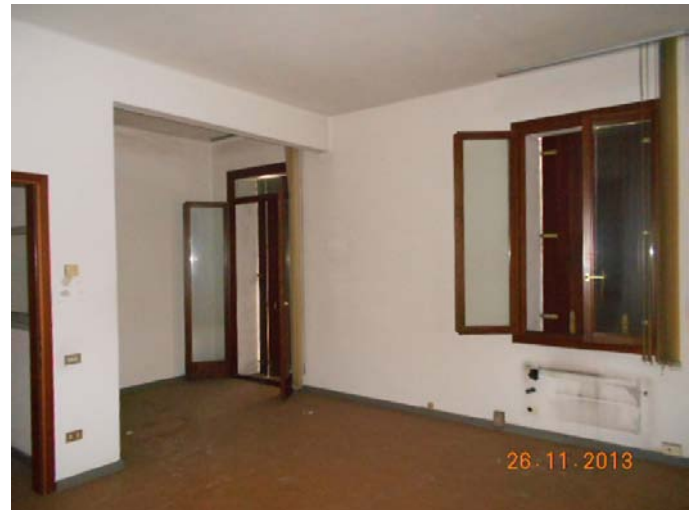
palazzina uffici: interno 10
