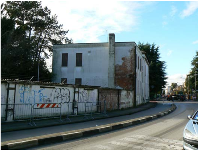
palazzina uffici: angolo nord-est
