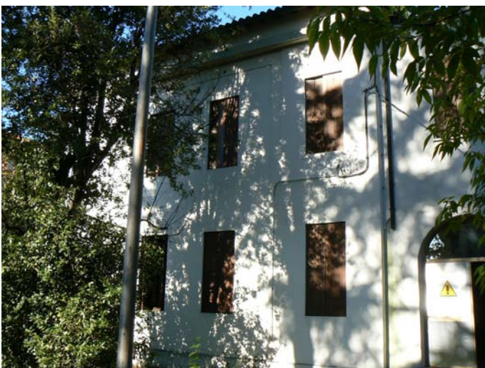
palazzina uffici: prospetto sud
