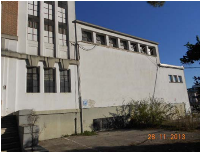
ex centrale del latte: prospetto ovest
