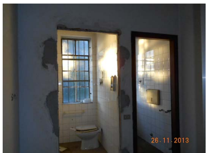
ex centrale del latte: interno 9 P.T.
