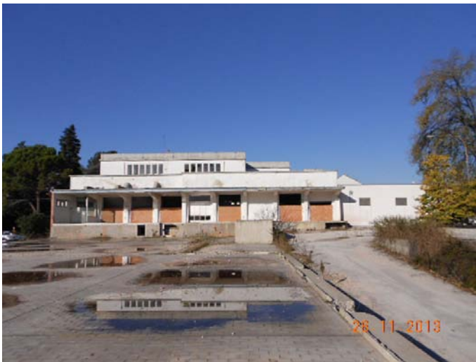
ex centrale del latte: prospetto sud
