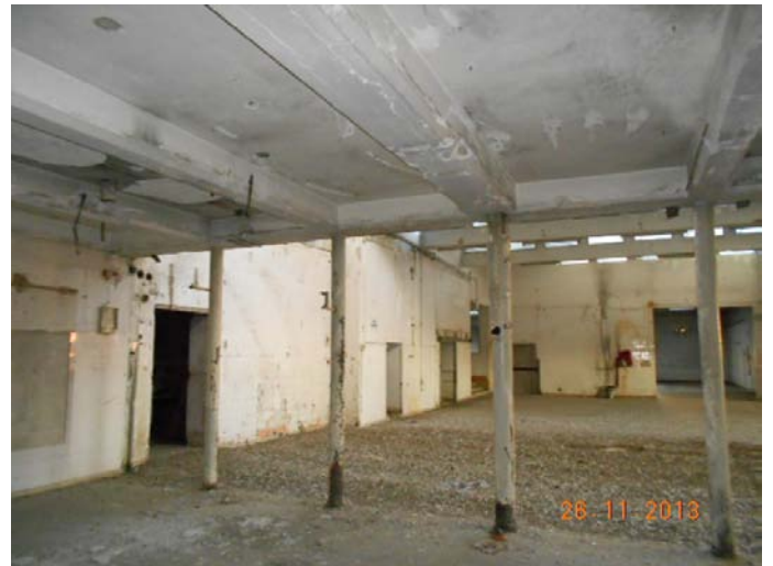
ex centrale del latte: interno 11 P.T.
