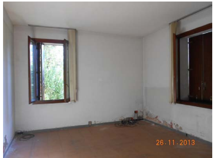
palazzina uffici: interno 4
