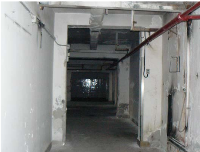
ex centrale del latte: interno 6 P.INT.
