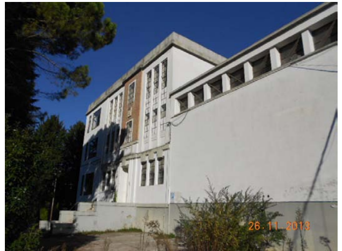
ex centrale del latte: prospetto ovest
