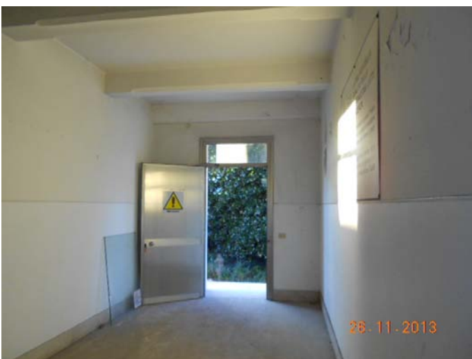
ex centrale del latte: interno 8 P.T.
