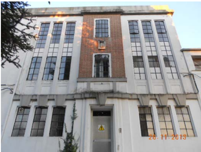
ex centrale del latte: prospetto ovest
