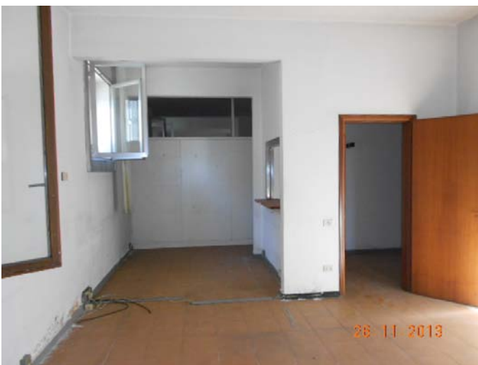
palazzina uffici: interno 5
