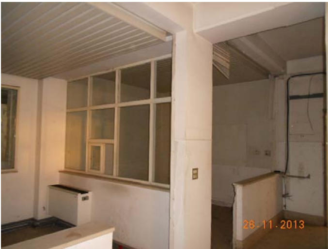
ex centrale del latte: interno 10 P.T.
