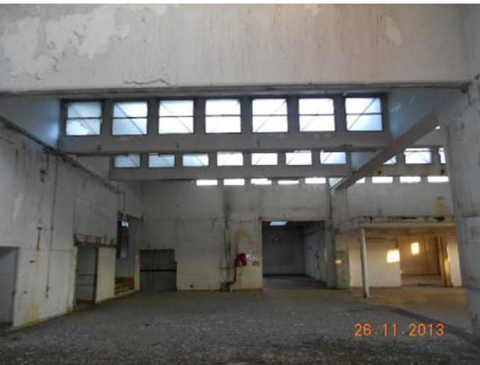
ex centrale del latte: interno 12 P.T.
