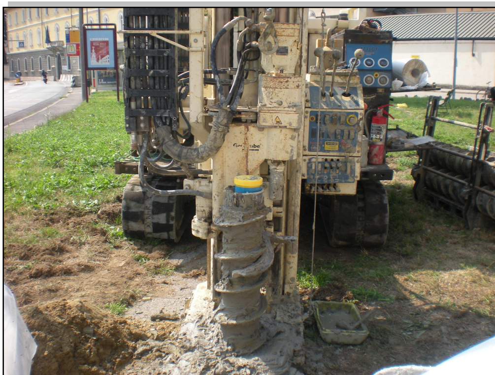
Foto 2: Infissione del piezometro nel foro di sondaggio P3
