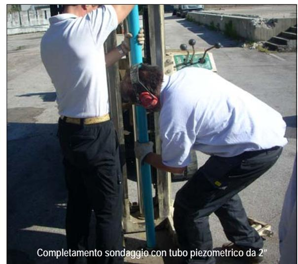
Completamento sondaggio con tubo piezometrico da 2"
